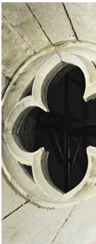
Bauarbeiter haben dieses Fenster aus dem 15. Jahrhundert entdeckt.
